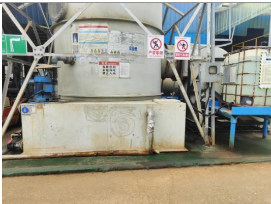
二车间酸雾吸收塔地坪硬化情况 (与絮凝剂生产线、锌资源生产线共用)
