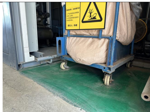
四车间（二车间和四车间共用）废水处理装置 地坪硬化情况
