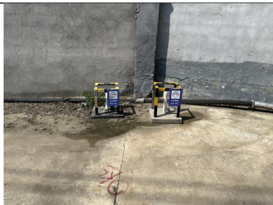
厂区内设置的地下水监测井
