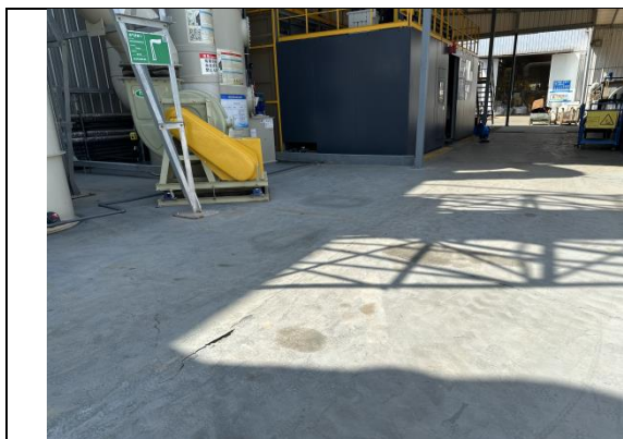
五车间废水、废气环保处置装置地坪硬化情况
